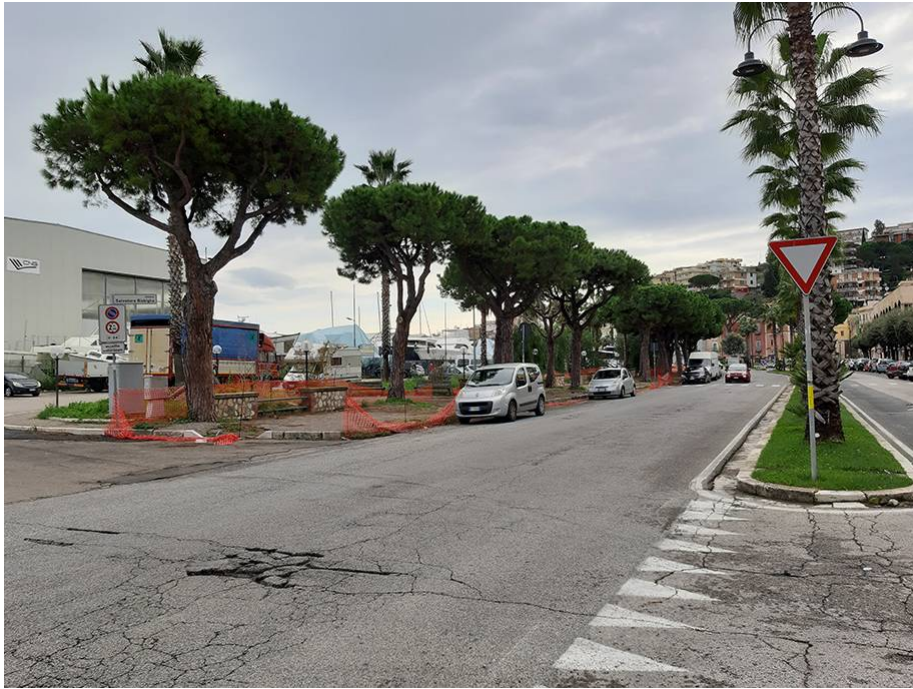
Panoramica del marciapiedi interessato dai lavori in direzione sud est
