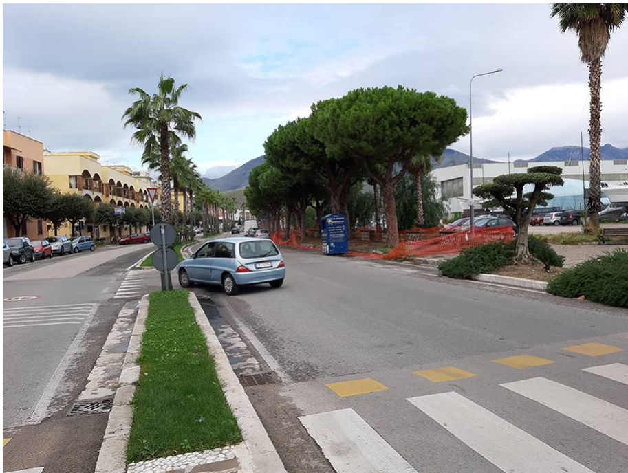
Altre panoramica del marciapiedi interessato dai lavori in direzione sud est
